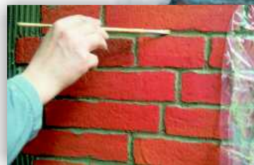
Došpárovanie a čistenie detailov
