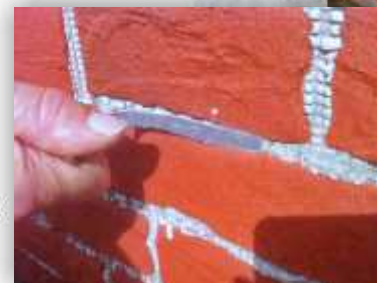
Špárovanie zavädnutého tmelu špárovačkou
